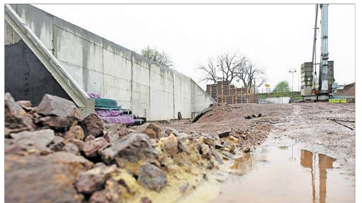
Mauerbau im Kurpark: Mit dem Baufortschritt sind die Oberhofer Stadträte, aber auch Bürgermeister Thomas Schulz nicht zufrieden. Demnächst soll es einen Ortstermin mit den Baufachleuten geben. Foto: Michael Bauroth
