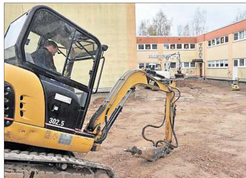
Die Bauarbeiter sind mit ihren Baggern fleißig im Eingangsbereich des Fröbel-Kindertagesstätten. Zunächst wurden die alten Bodenplatten entfernt, und seitdem schreiten die Arbeiten zügig voran.
