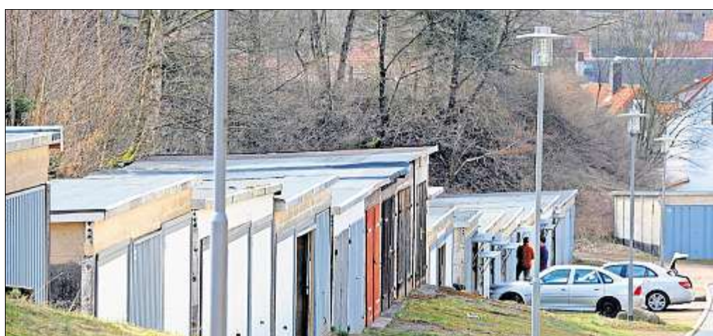
Die teilweise stark verschlissenen Garagen in der Zella-Mehliker Heine-Straße sollen abgerissen werden. Noch im April werden die Arbeiten beginnen. Foto: frankphoto.de
