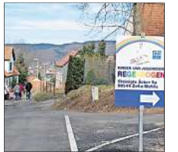
Die Steinigten Äcker werden grundhaft saniert. frankphoto.de
