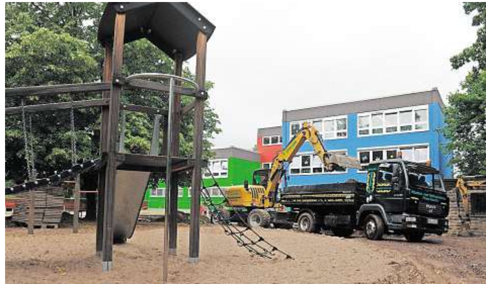
... was Bagger, Laster und Co auf dem oberen Spielplatz ihres Kindergartens machten. Bis Ende Oktober laufen hier umfangreiche Erneuerungsarbeiten. Fotos (2): frankphoto.de
